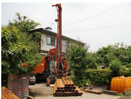
既設家屋の地中熱交換器施工
